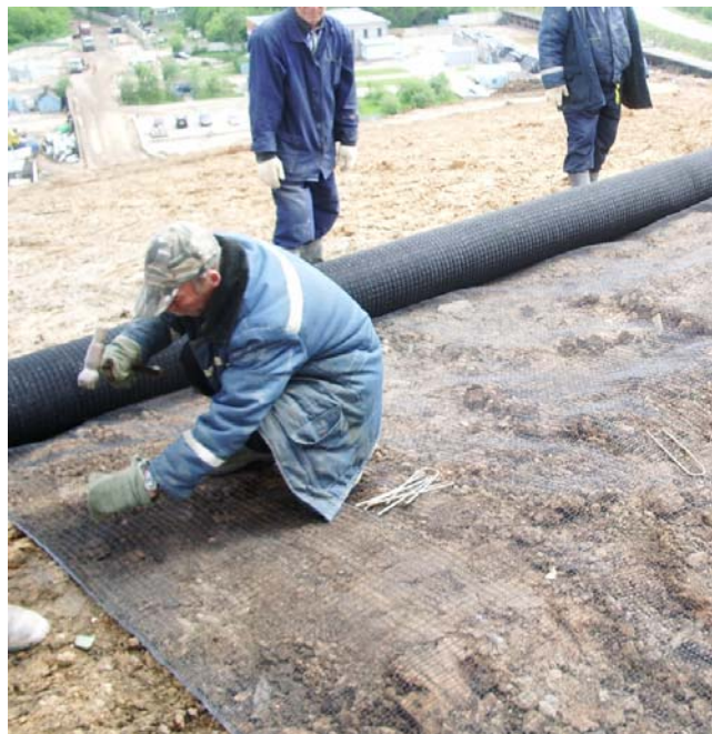
Рис.4 Анкеровка материала
