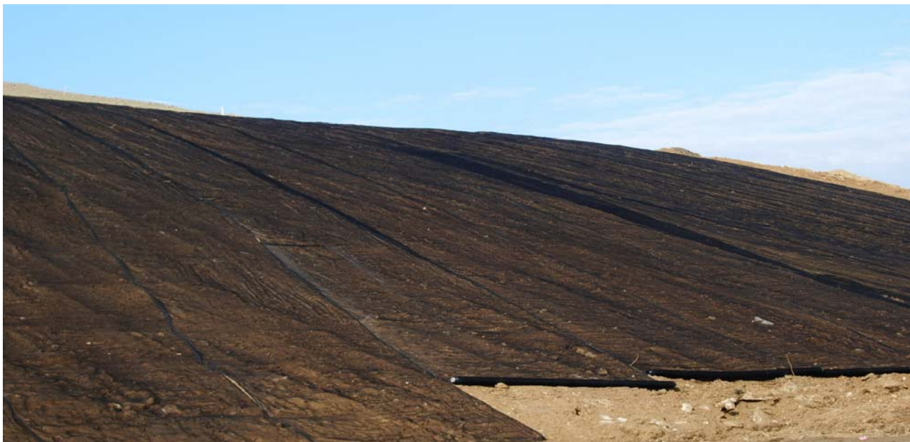
Рис.4 Укладка последующих полотен мата Геосклон 3D
