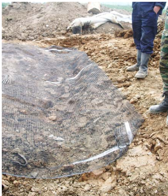
Рис.3 Укладка в анкерную траншею.
