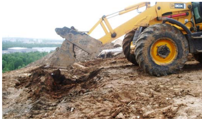
Рис.2 Рытье анкерной траншеи
